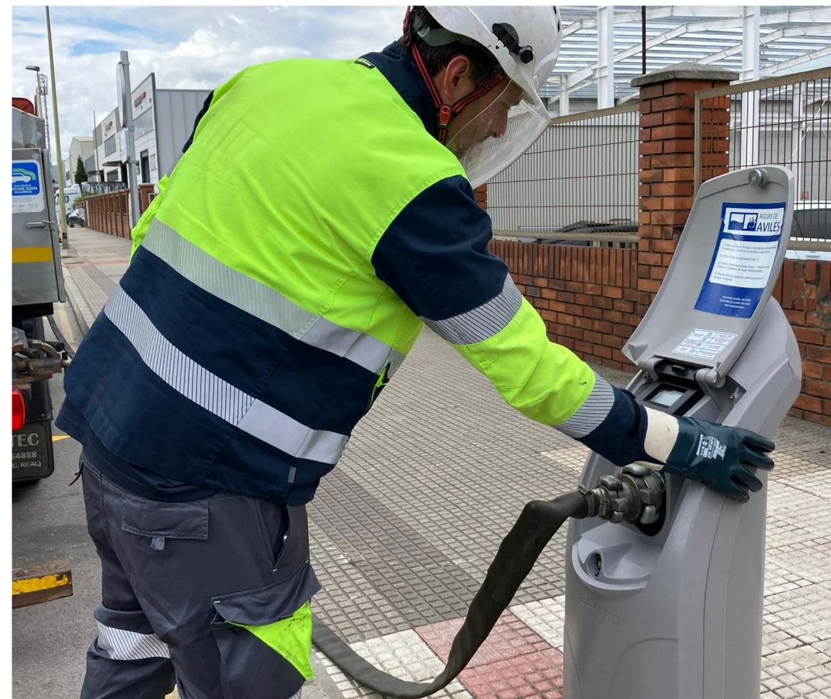
Un operario colocando la manguera del camión de saneamiento en la boca de carga.
