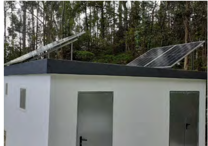
Rehabilitación manantial de La Fervencia
