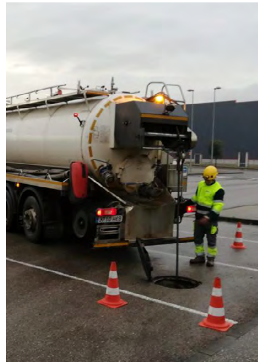
Trabajos de limpieza preventiva de alcantarillado
